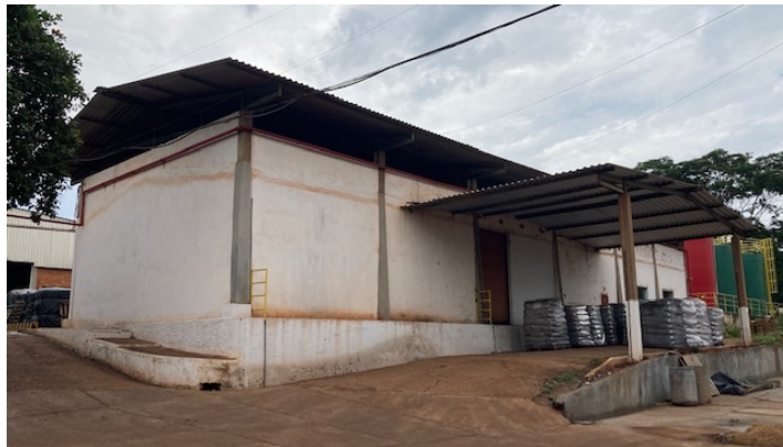
Galpão para armazenamento de carvão
