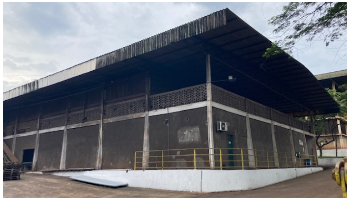
Galpão 3 para aproveitamento de babaçu
