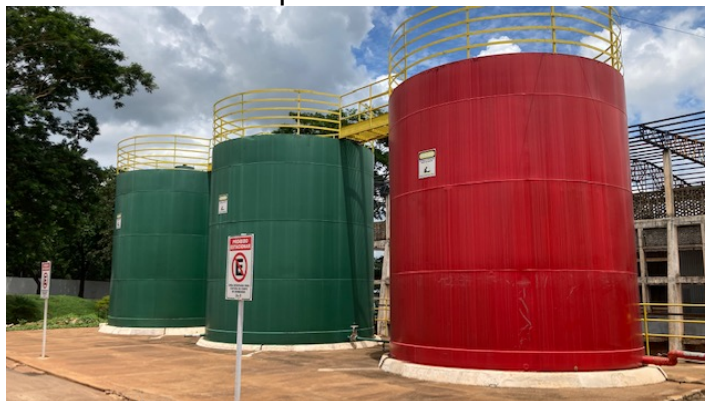
Tanque de aço e carbono, 100 mil litros
