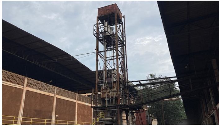
Estrutura das colunas de destilação
