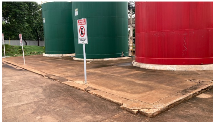
Base de concreto dos tanques
