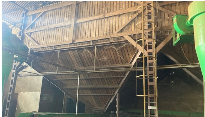
Silo de madeira para babaçu
