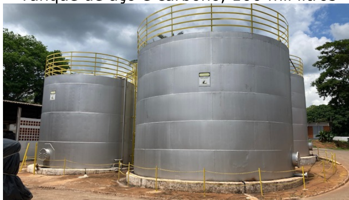
Tanque de aço carbono para óleo de babaçu, 100 e 200 mil litros
