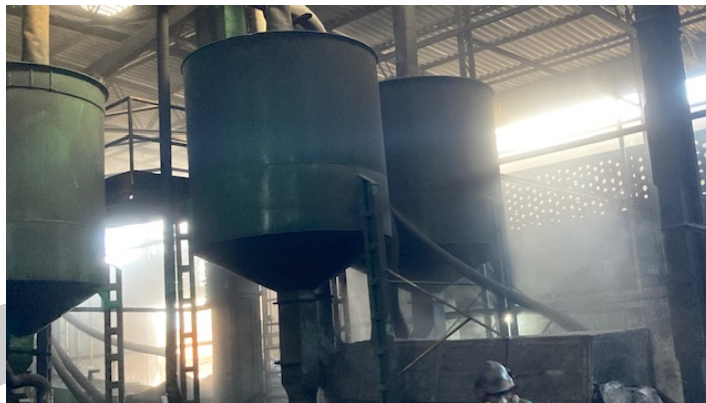
Silo de mesa densimétrica
