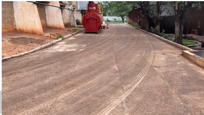
Calçamento das vias
