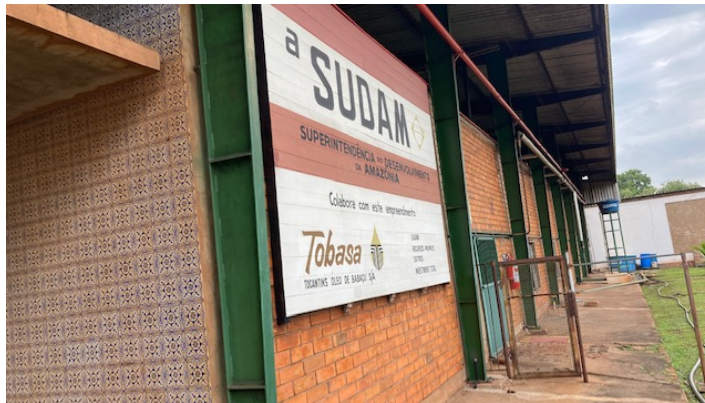
Estrutura do galpão de óleo de babaçu LOTE URBANO – MAT. 387
