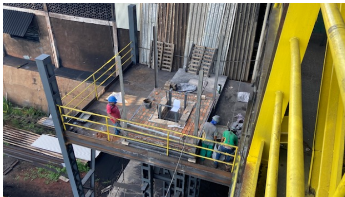
Forno em construção
