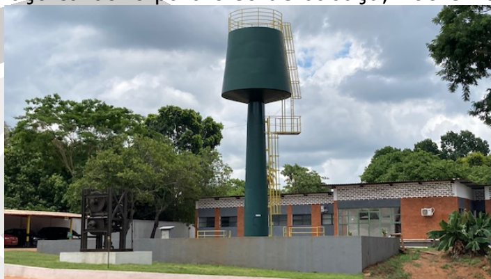
Tanque de água com capacidade para 50 mil litros
