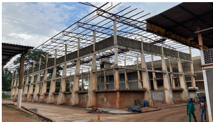
Depósito em reforma
