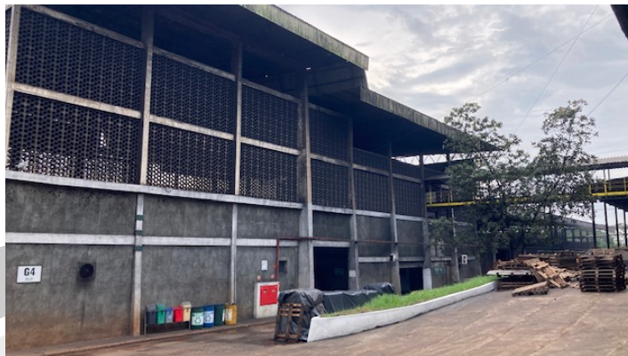
Galpão 4 para carboativação de babaçu
